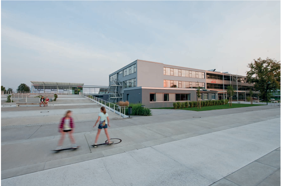
Schul- und Kulturzentrum Feldkirchen an der Donau: Sieger ETHOUS Award 2015 "Öffentliche Bauten"; Architektur: FASCH+FUCHS ZT GmbH; Verarbeitung: Leitner Gebäudedämmung Foto: Hertha Hurnaus
