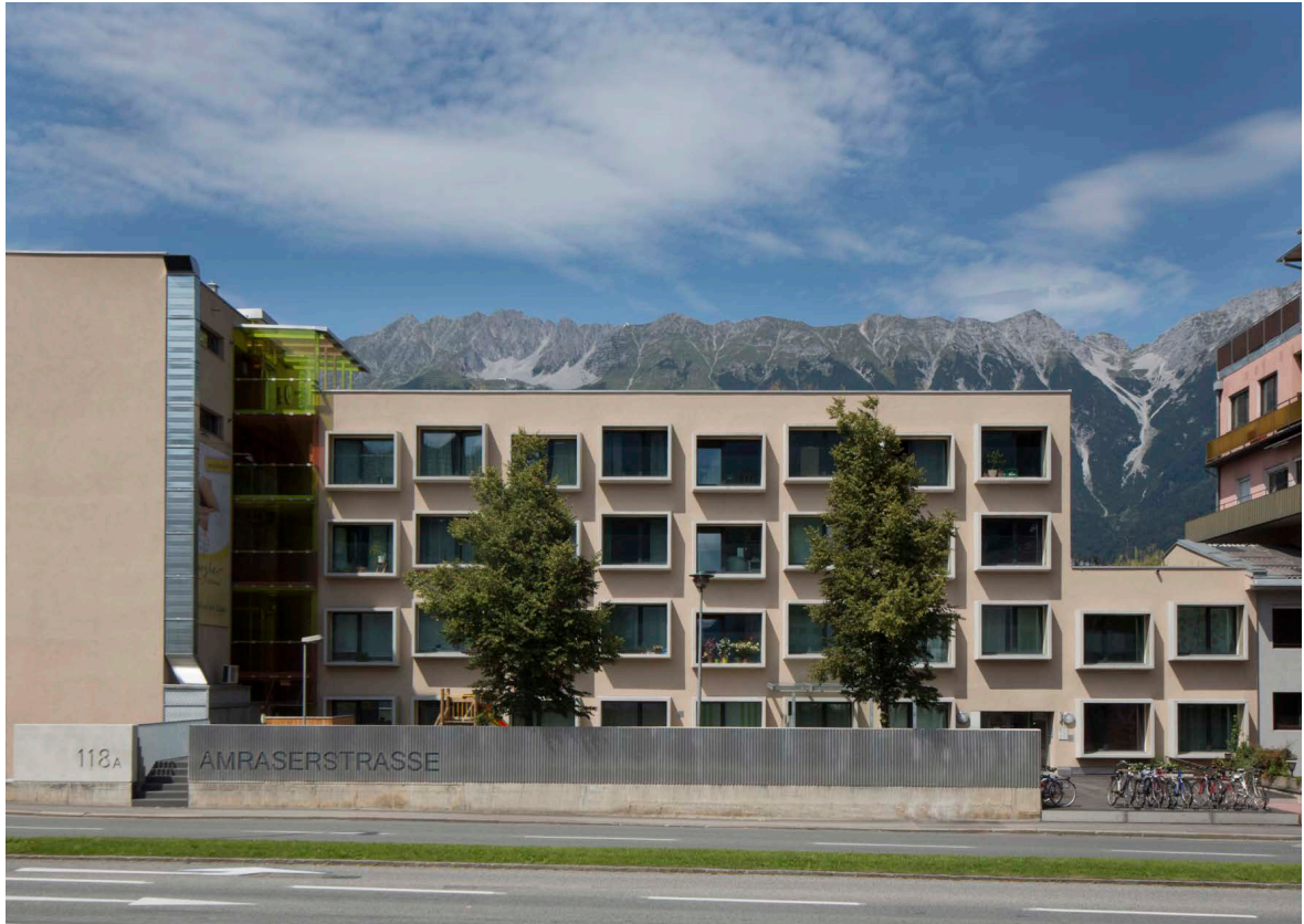
Amraserstrasse 118, 6020 Innsbruck: Sieger ETHOUSE Award 2015 „Wohnbau“; Architektur: U1architektur; Verarbeitung: SP-Bau GmbH; Foto: Birgit Köll
