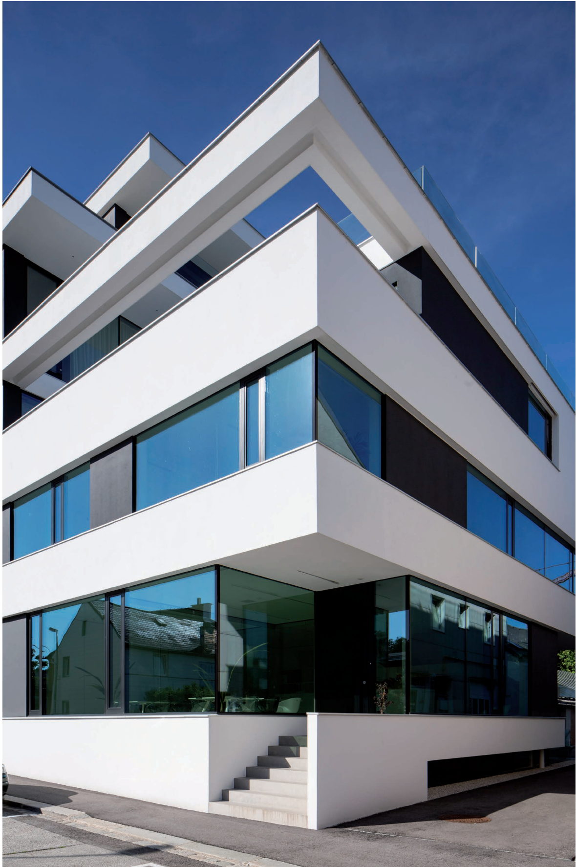
Energieautarkes Stadthaus, Wels: Sonderpreis „Gewerbliche Bauten“ ETHOUSE Award 2013; Architektur: PAUAT Architekten ZT GmbH; Verarbeitung: Wandl Der Maler GmbH Foto: Heinz Plöderl, PAUAT/Luttenberger
